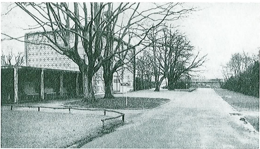
Mariebjerg , Gentofte. Bygget 1934–36. Arkitekt Frits Schlegel. 974 kremationer i 1970. I alt pr. 31. 12. 70: 19.396. Krematoriet drives af kommunen.
