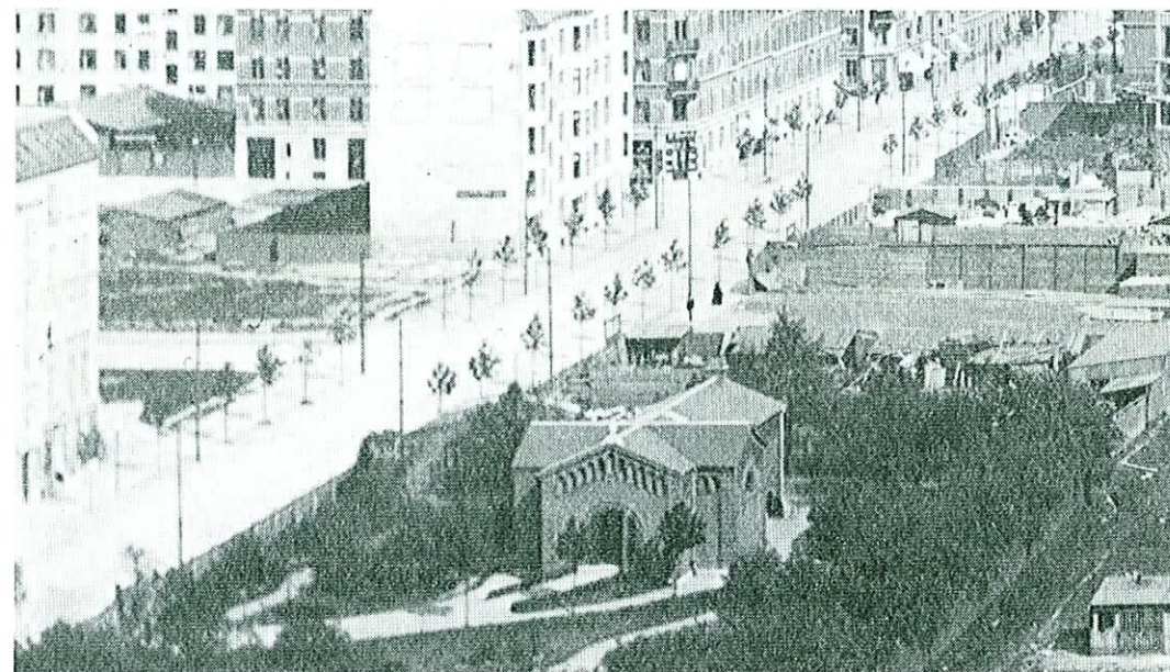
Det første krematorium på Nylandsvej (nu nedrevet).
